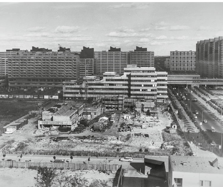
Blick auf den Rohbau des Gemeindezentrums um 1971.
